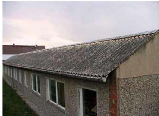
Asbestprodukte sind von Laien augenscheinlich schwer zu erkennen. Typisch sind eine weißgraue/blaugraue Färbung und eine faserige Struktur bzw. abstehende Fasern an Bruchstellen. Einen wichtigen Hinweis liefert der Herstellungszeitraum der Bauteile bzw. der Gebäude. Bei alleiniger augenscheinlicher Betrachtung besteht die Möglichkeit, dass Asbest mit den später verwendeten Ersatzstoffen, z. B. Glasfasern, Gesteinsmehl-Platten oder Mineralfasern, verwechselt wird.
